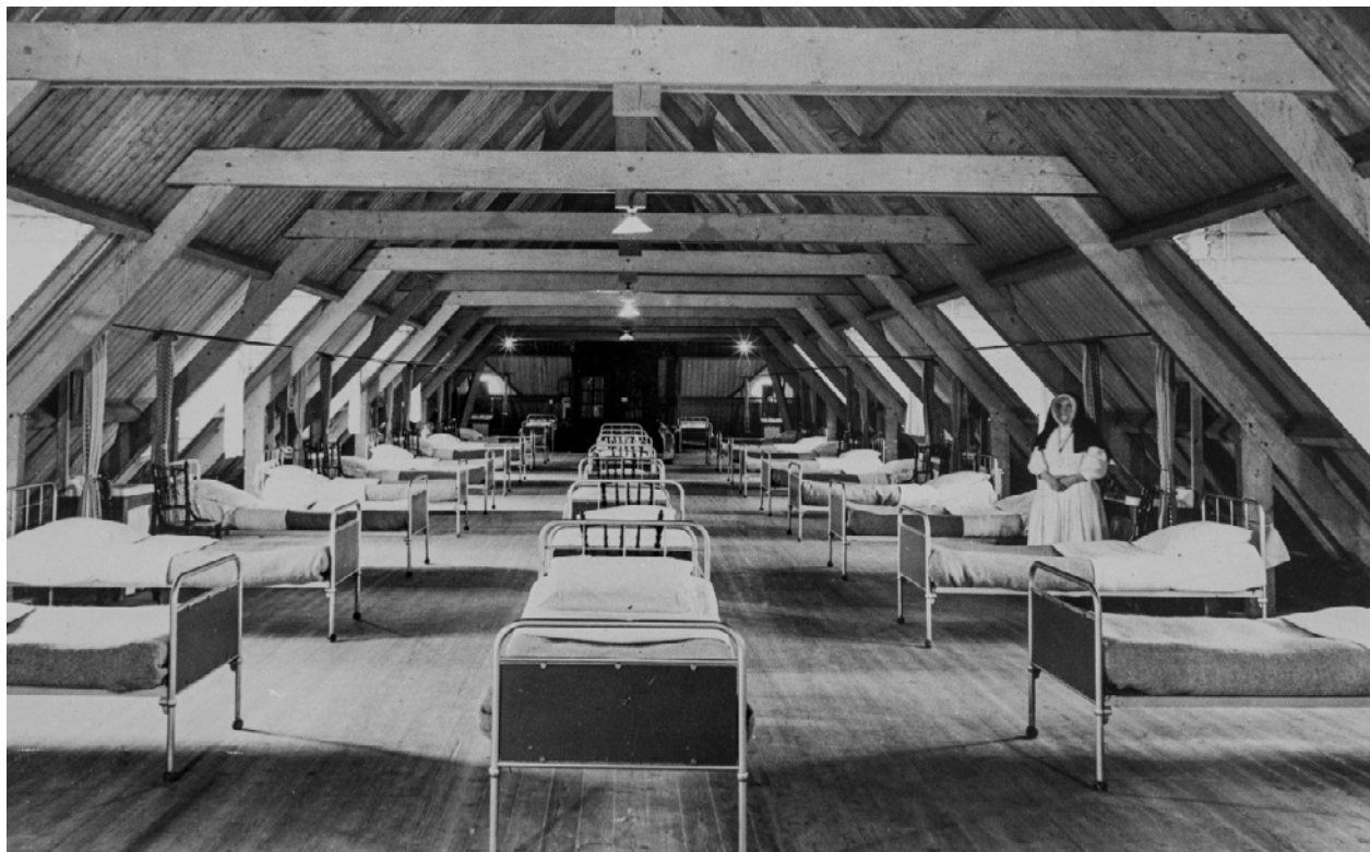
Doorgangshuis op de zolderverdieping tussen de jaren twintig tot midden jaren zestig. Daarna verplaatst naar het hoofgebouw.
